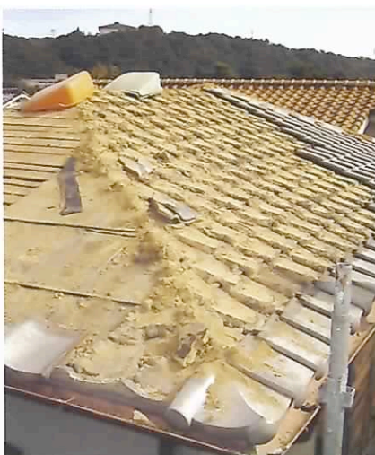
①土及び屋根瓦葺き 撤去
