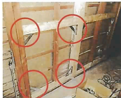
㉖耐震補強金物工事中
