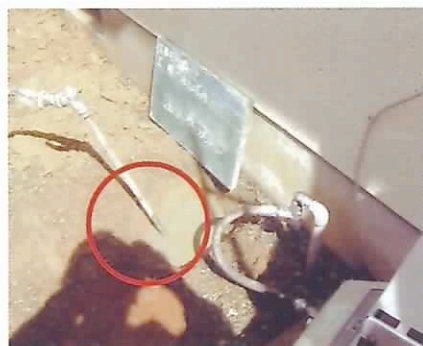
㉕外部からの地盤改良 (改良剤注入)
