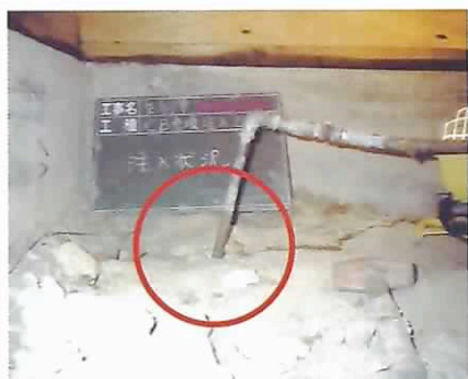
㉔床下から行う地盤改良 (改良剤注入)
