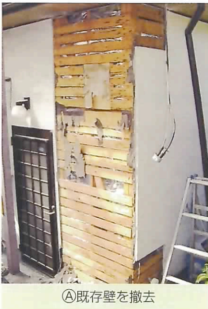
②耐震かべ補強キットによる壁の補強
