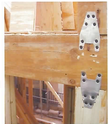
③柱頭・柱脚部 補強金物設置
