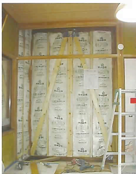
内部からの筋交いと金物による補強
