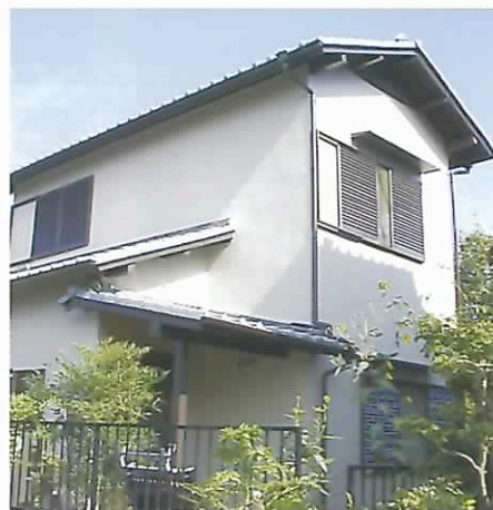
外壁改修 完了
