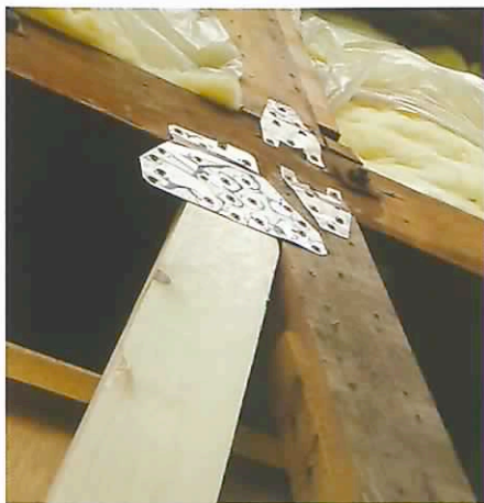
柱頭・柱脚部 補強金物設置
