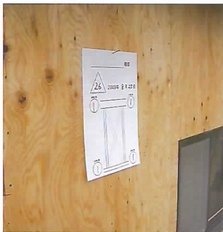
外壁構造用合板張り
