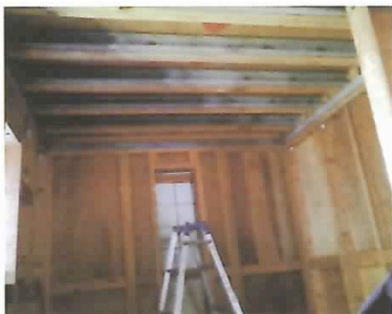
シェルター 壁、天井施工中
