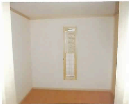
シェルター 完成（内部撮影）
