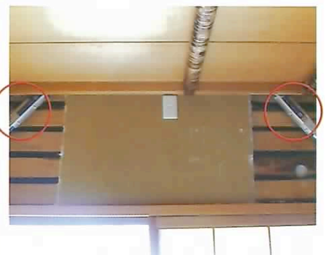
制震ダンパー 取付後
