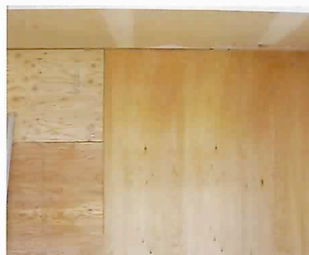
構造用合板張り
